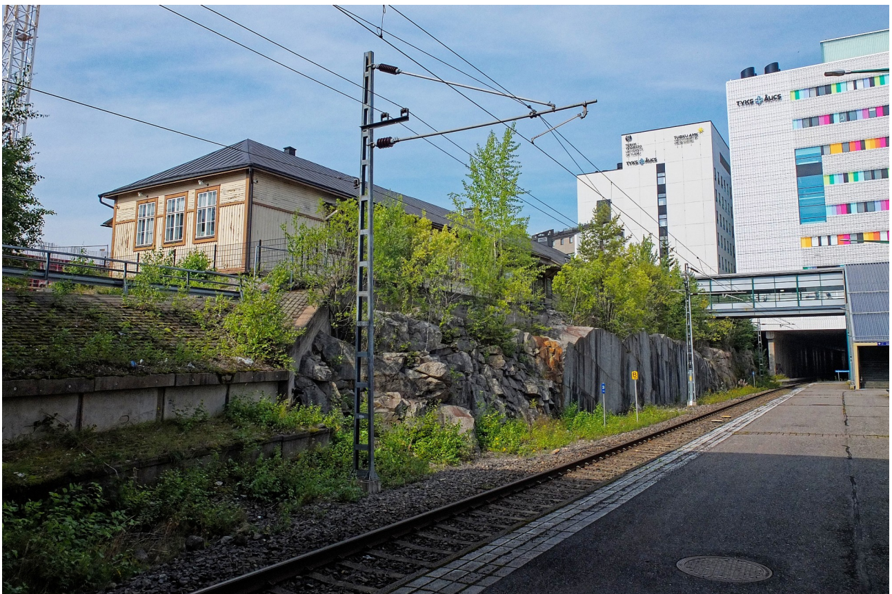
Kupittaa 18.8.2022 Maalipinta alkaa olla jo aika huonossa kunnossa.
